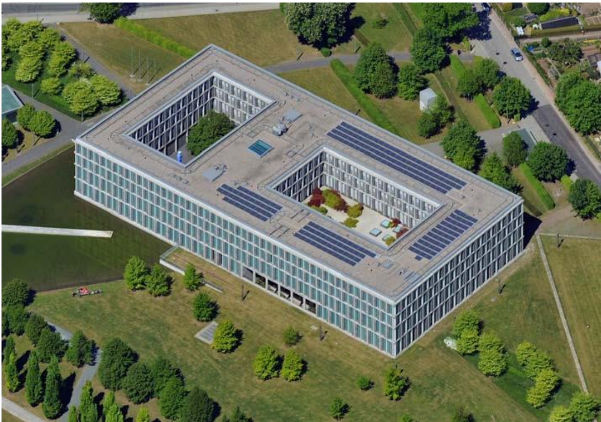
Luftaufnahme des Gebäudes des Bundesarbeitsgerichts auf dem Petersberg in Erfurt.
